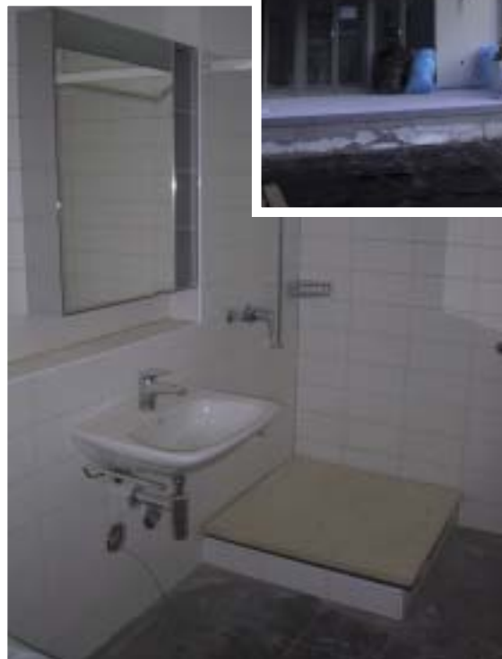
Einblick in Dusche, WC, Lavabo (Stand 28.11.2005; Bau-Endreinigung noch nicht erfolgt)
